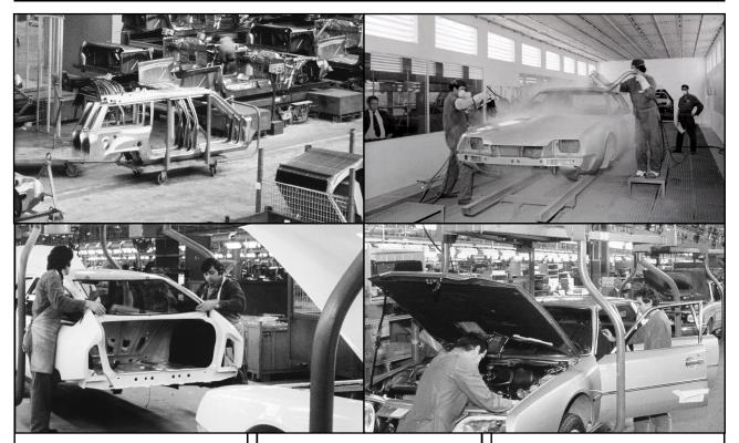
maticamente a un immenso magazzino multipiano e spedite nel reparto di montaggio su tre linee per ricevere gli interni, coordinati con il colore esterno, i cristalli e la meccanica.
